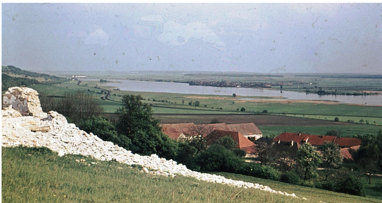
Velkostatek Stará Bář před demolicí, vlevo vpředu rozvaliny hájovny
