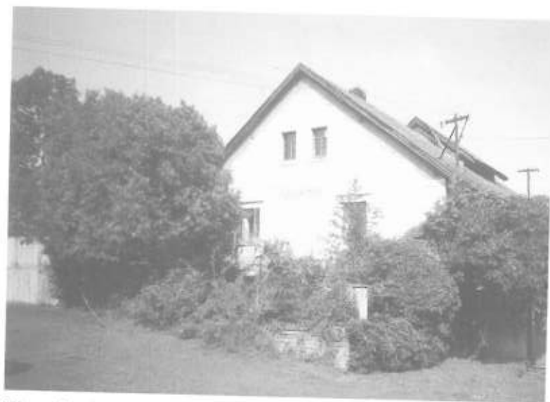
VÁLCOVÝ MLÝN V BOŠICÍCH (FOTO Z R. 2005)
