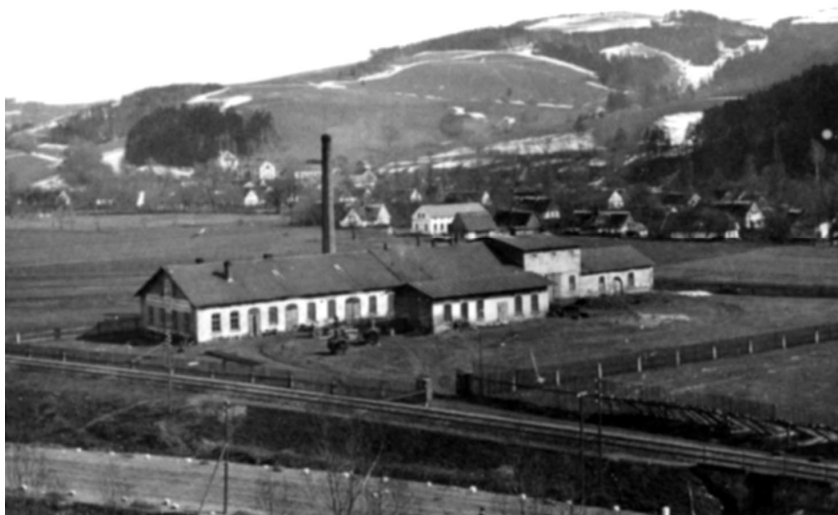
Obr. - Slévárna Ing. Kašpara v Náchodě v Bělouši. / Z archivu A. Samka. /
