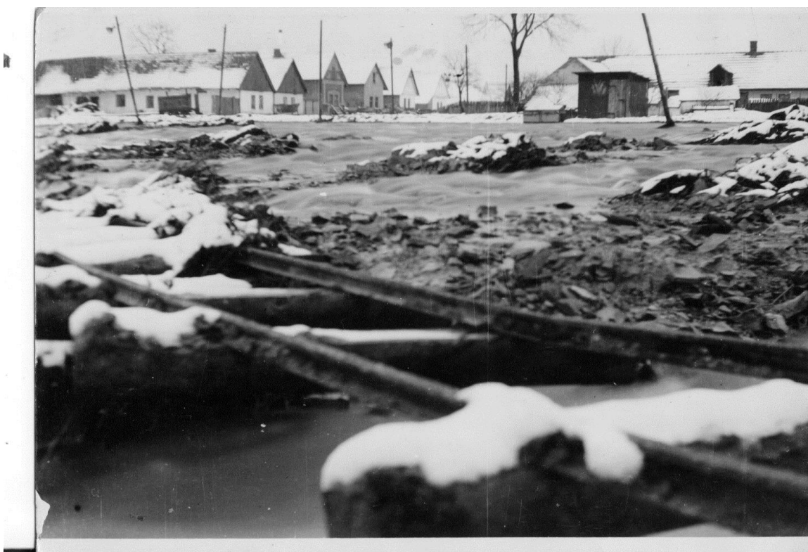
Povodeň při rekonstrukci rybníka 31. ledna 1953 na části obce Čuraje
