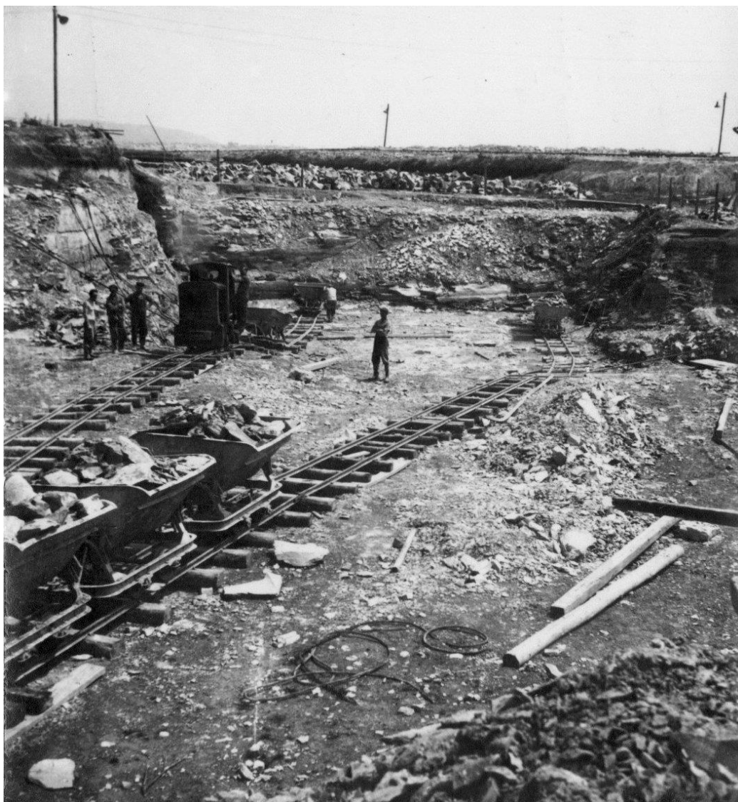
V závěru rekonstrukce rybníka pracoval vláček při úpravě nového řečiště
