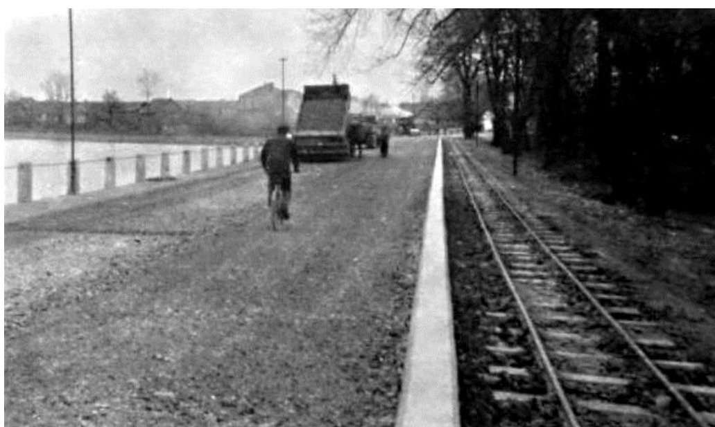
Práce na silnici po dokončení úprav rybníka – konec padesátých let 20. století
