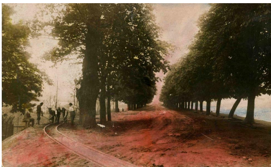
Práce na trati úzkokolejné železnice u dubu v roce 1924
