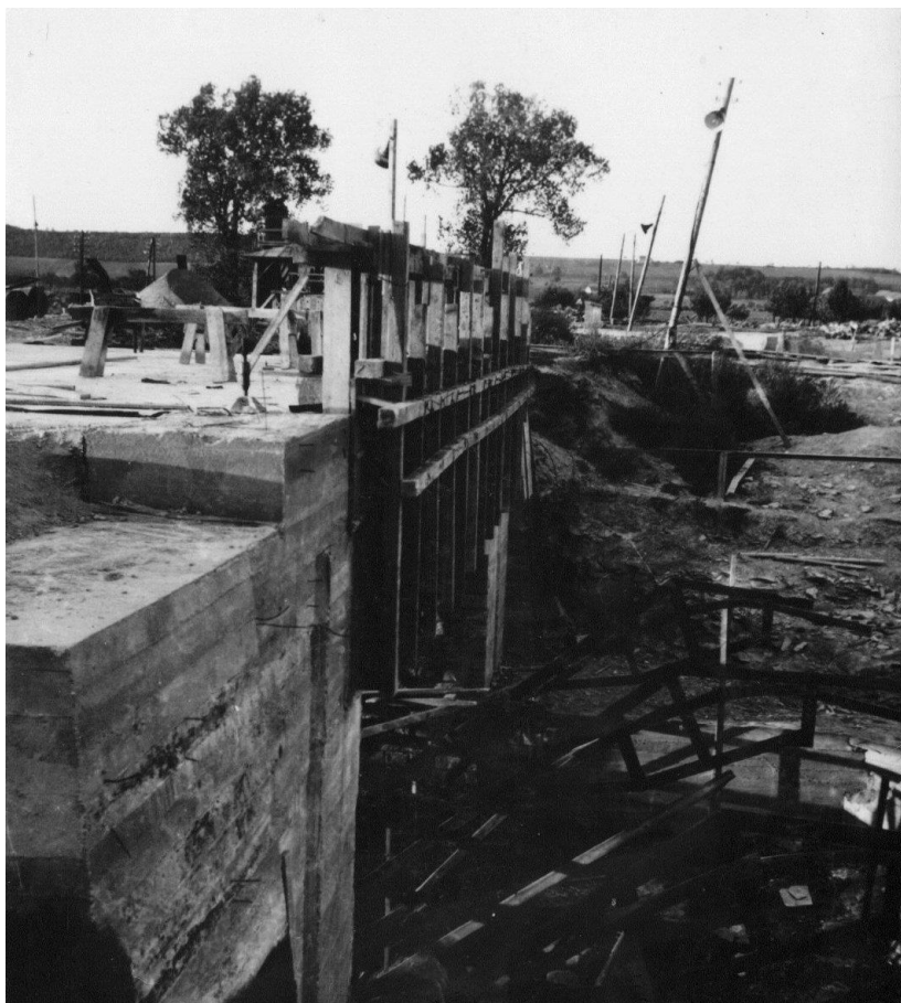
Budování klapky při rekonstrukci rybníka
