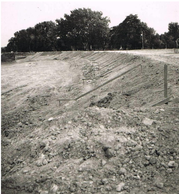
Vyrovnání hráze do mírného oblouku při úpravách rybníka v padesátých letech
