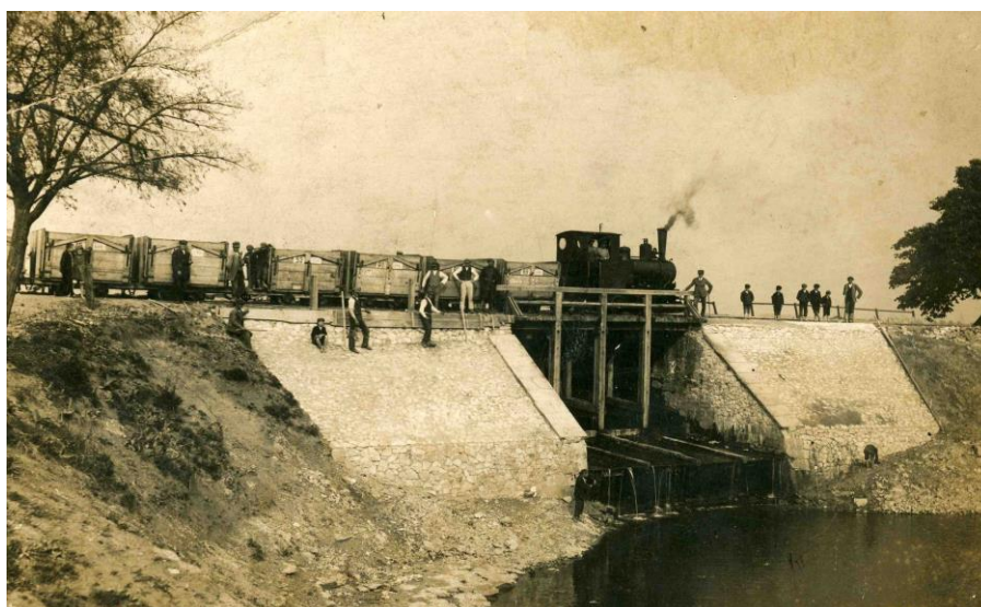
Vlak na mostě Na Skále v roce 1926
