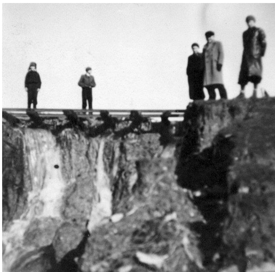
Protržená hráz při jedné z povodní před rekonstrukcí rybníka
