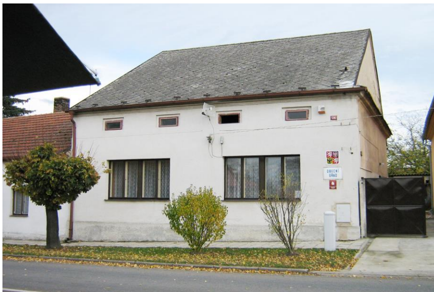
Budova obecního úřadu čp. 136
