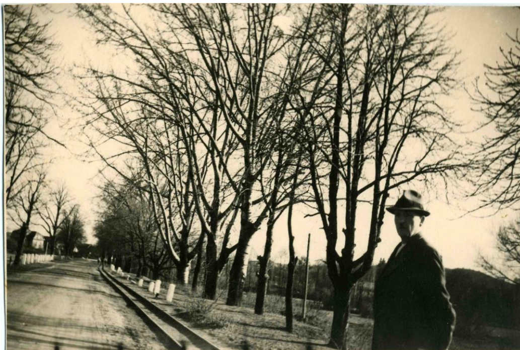
Koleje řepařské malodrážky před vybudováním betonového pásu
