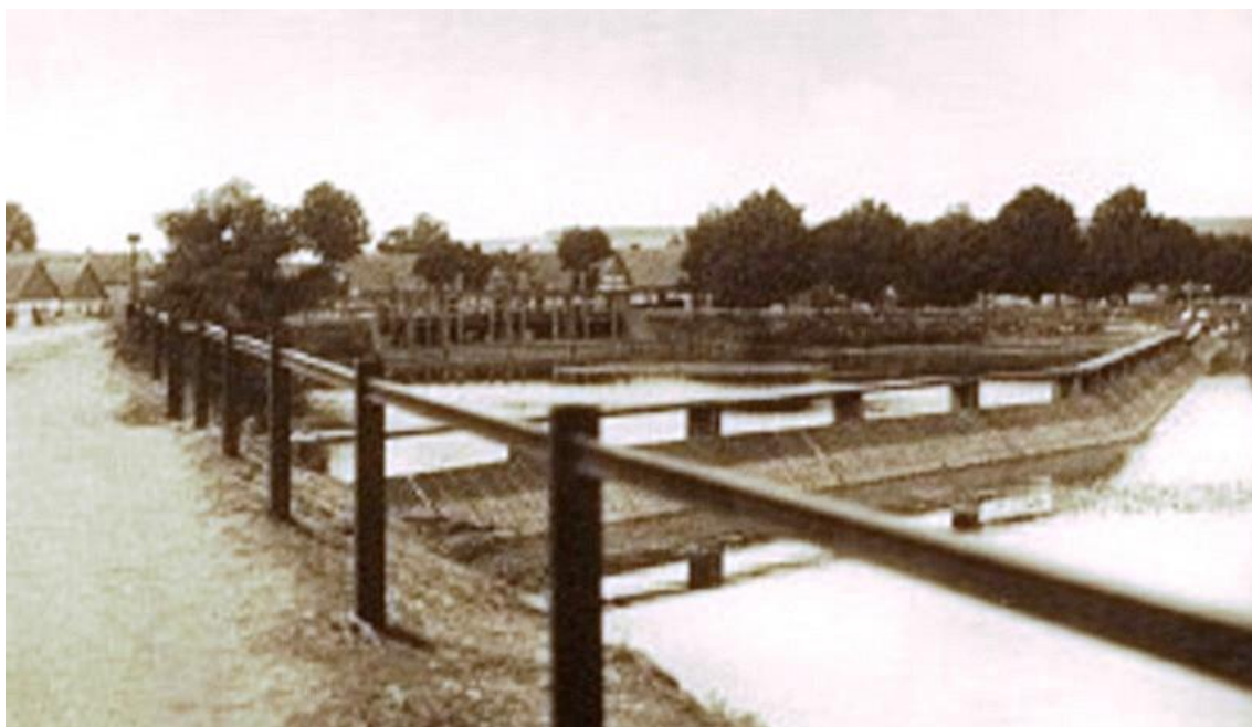
Staré česlice v rybníce bránily úniku ryb při odtoku vody splavy Pod Skálou a Pod Osmi
