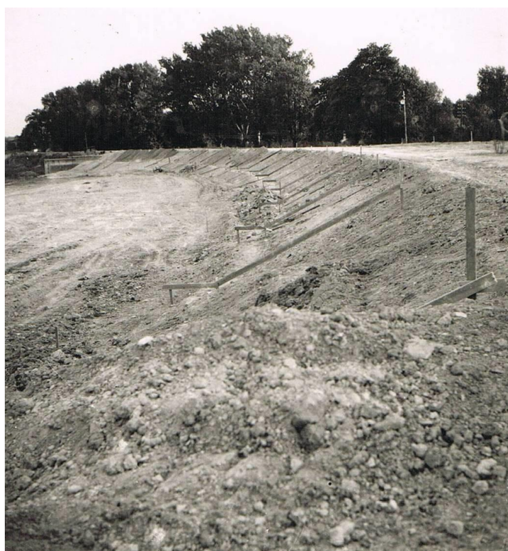
Zvyšování, rozšiřování a vyrovnávání hráze do mírného oblouku
