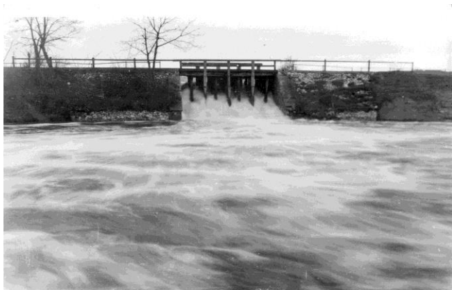
Splav Pod Skálou za vypouštění velké vody
