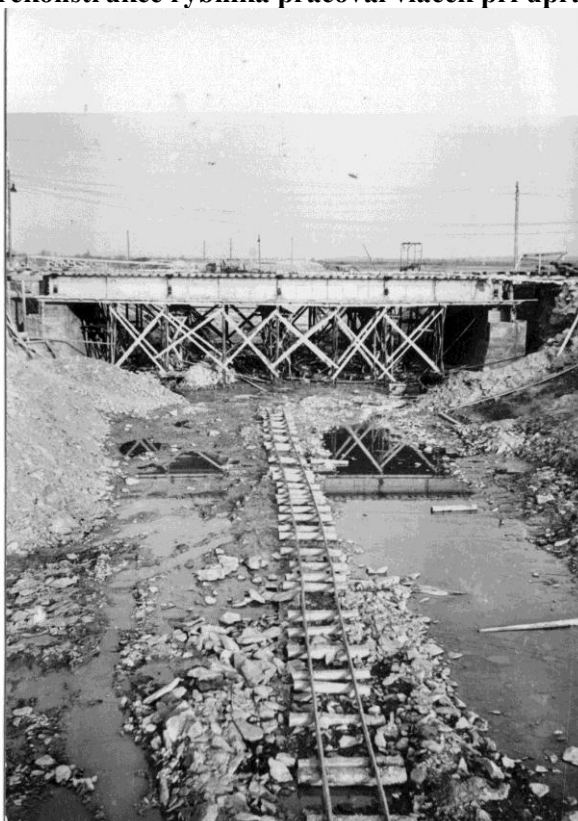
V závěru rekonstrukce rybníka pracoval vláček při úpravě nového řečiště
