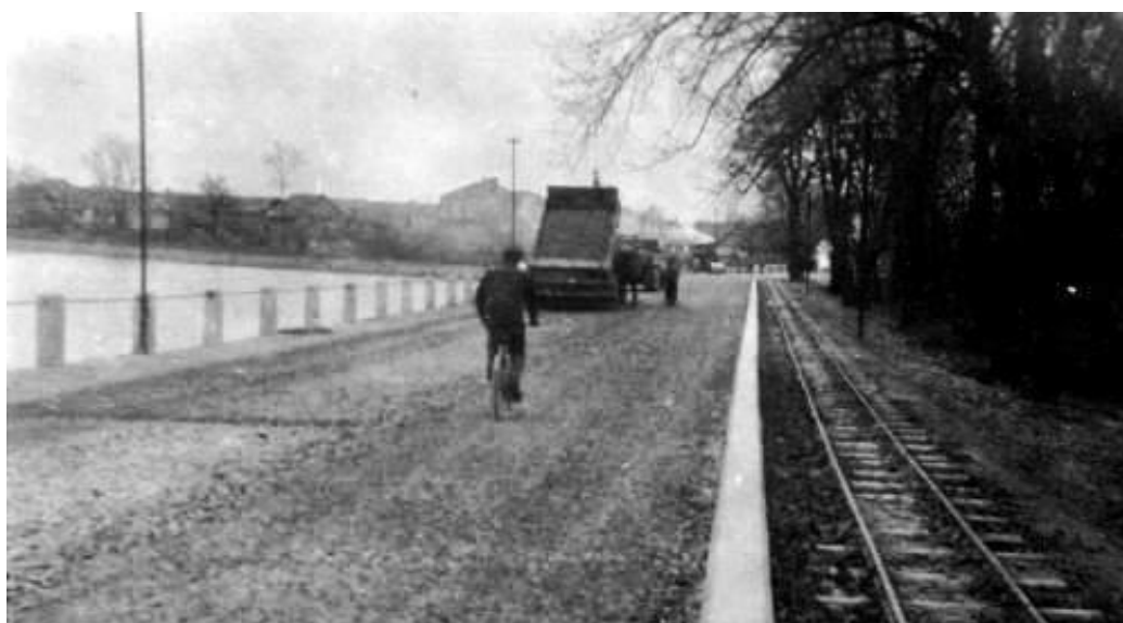
Zde vidíme v závěru prací hotový betonový pás oddělující kolejiště malodráhy od silnice
