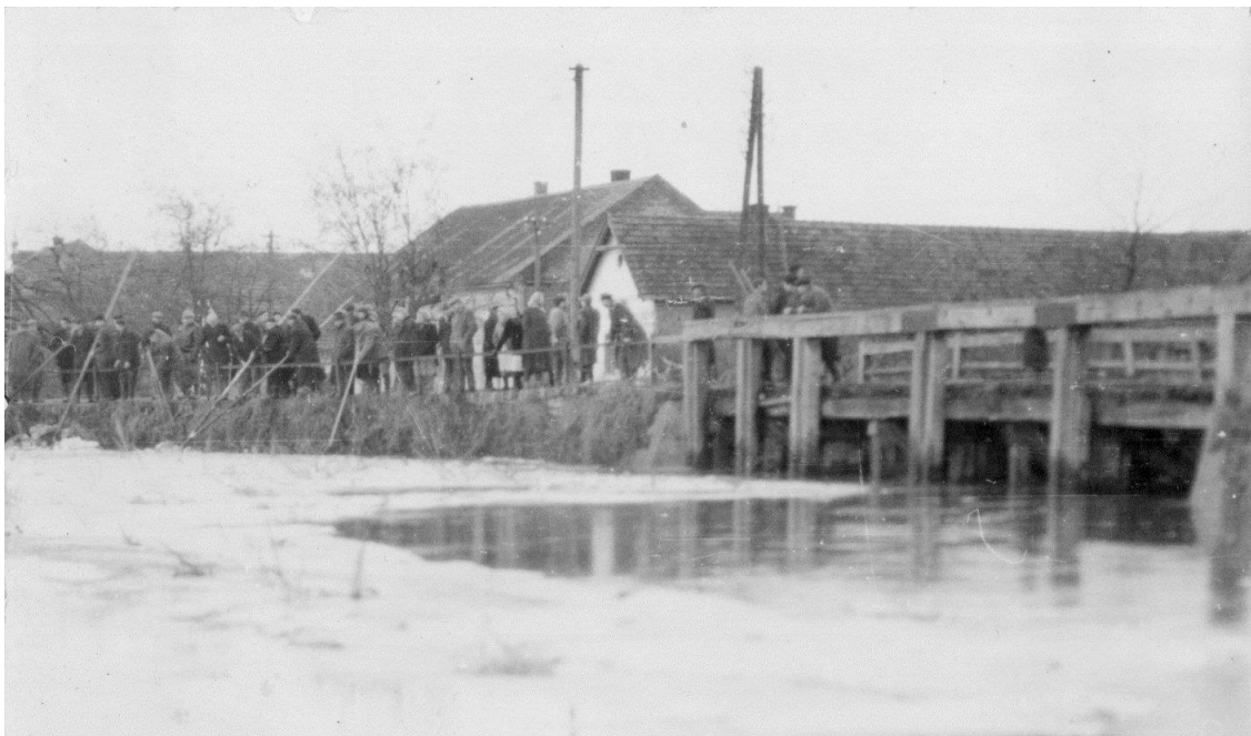
Povodeň 31. ledna 1953 – rozbíjení a odstraňování ker v rybníce před stavidly Pod Osmi
