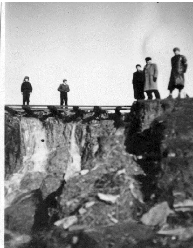
Hrozbou Malé Strany a Čurají bývaly od pradáva až do úprav rybníka povodně, zde vidíme poškozenou hráz při povodni v roce 1947.
