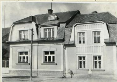
Vilka p. Šrámna, postavená r. 1912. Dům p. Chrástného po přestavbě.
