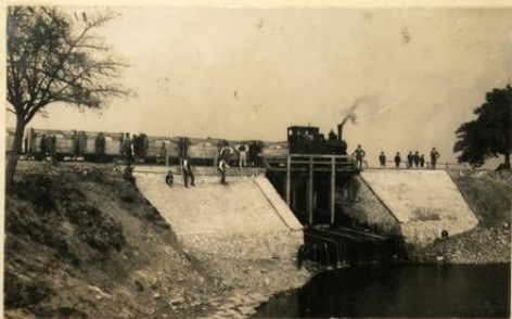
Opravený splav „Na Skále.“
