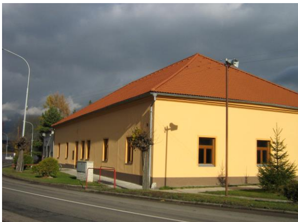
Čp. 11 – pohled od jihozápadu
